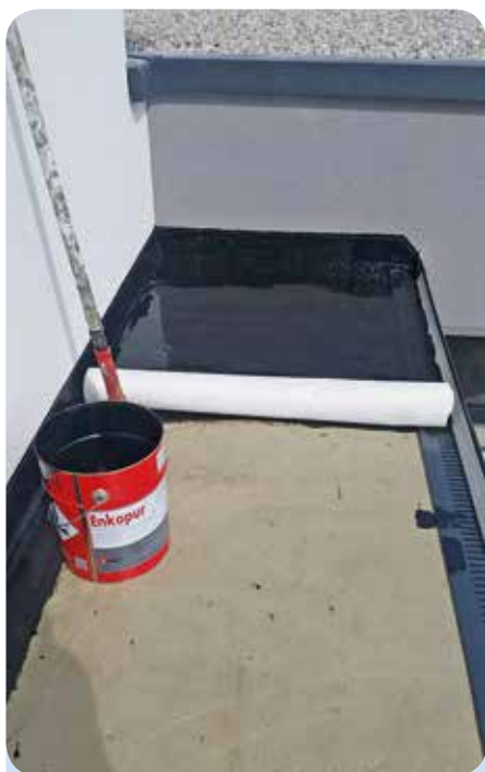
Auch die schwarze Variante des Enkopur-Systems besteht aus Enke-Voranstrich, Enke-Polyflexvlies-Bewehrung und Enkopur-Flüssigkunststoff.
