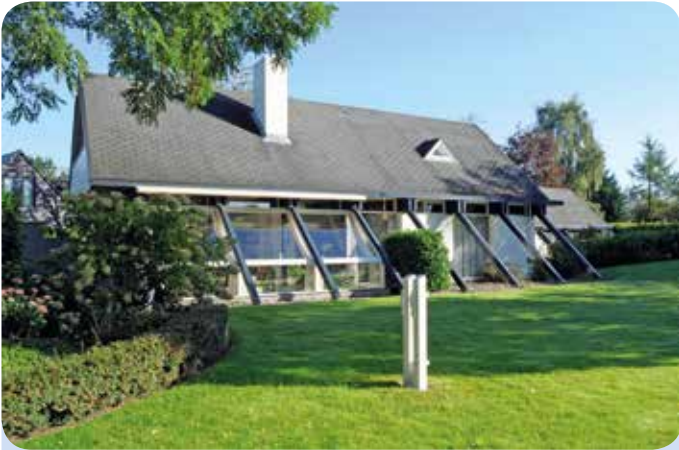
Insbesondere bei der Sanierung eines in die Jahre gekommenen Daches...
