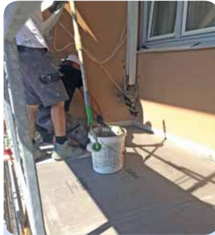
Die Verarbeiter brachten zunächst das Entkopplungssystem Triflex ProDrain mit der Matte DC-MAT auf.
