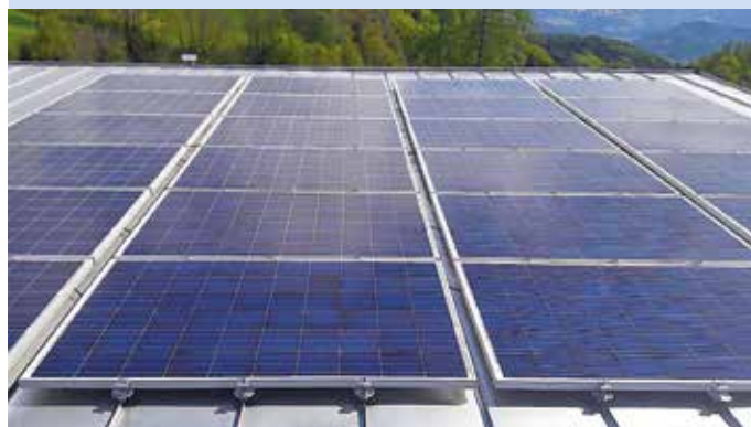
Photovoltaik-Montage auf S-5! Klemmen.
