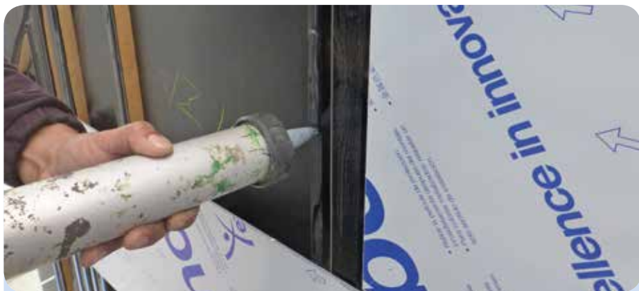
Der U-Wert der Fassade, vorher an schlechten Stellen 1.6 \text{ W/m}^2\text{K} , beträgt heute 0.15 \text{ W/m}^2\text{K} . Eine starke energetische Ersparnis, welche die Investition vollends legitimiert.
