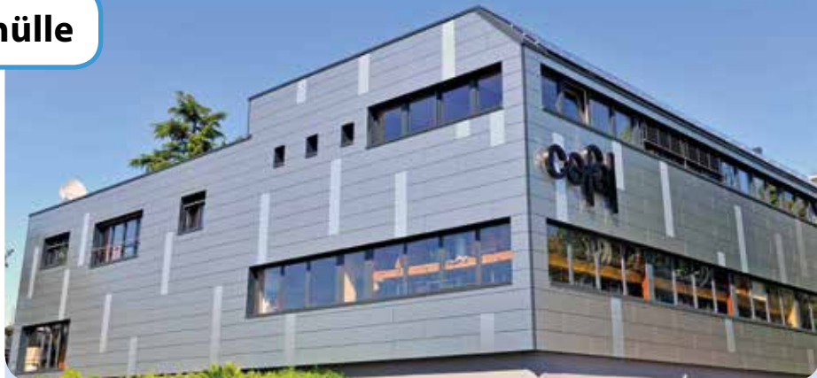
Um in der Wirkung der gebürsteten Flächen einen Kontrast zum Ausdruck zu bringen, wurde entschieden, einzelne Platten bewusst senkrecht zu verlegen.
