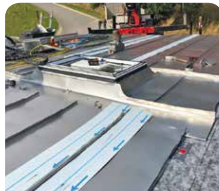
Bei diesem Projekt kamen rostfreie Edelstahlbänder „Uginox Top 44“ in mattgewalzter Oberfläche in der Abmessung 500 x 0,5 mm zum Einsatz.
