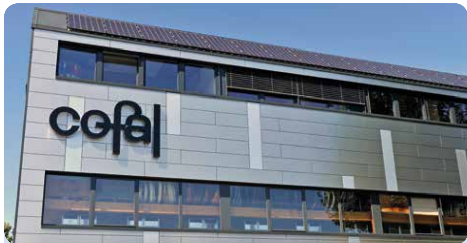
Man entschied sich für das flexible, wärmebrückenfreie Holz-UK-System U PSI Typ F, welches nachträglich mit Dämmplatten gefüllt wurde.
