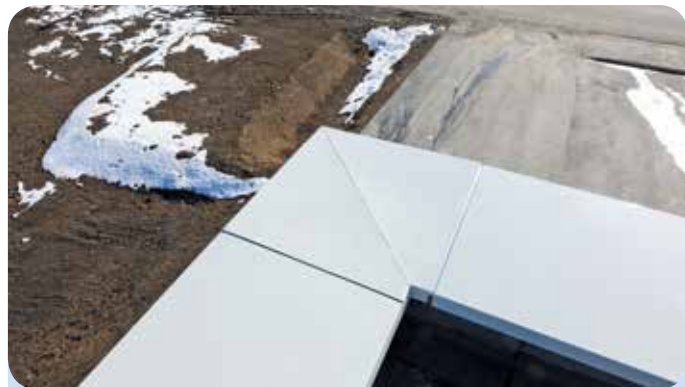
Passend zu den Profilen wurden die Außenecken der Attikaabdeckung angefertigt.
