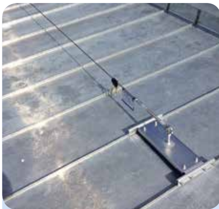
Sicher unterwegs auf dem Blechdach mit den Falz-Plus Anschlagpunkten von LUX-top®.
