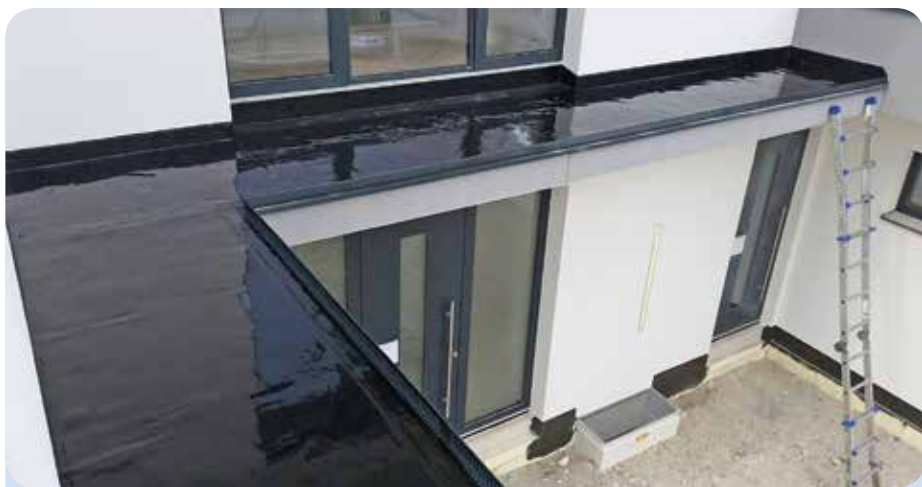
Enkopur ist immer dann die erste Wahl, wenn Abdichtungen in sogenannten Wasserwechselzonen mit länger stehendem Wasser sowie Dauerfeuchtbereiche ausgeführt werden müssen.
