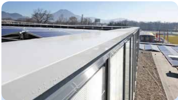
Attikaabdeckungen der Firma Richard Brink schützen den Übergang zwischen Dach und Wand vor eindringender Feuchtigkeit.
