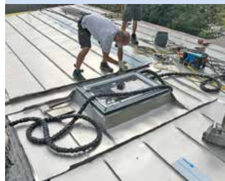
Rollennahtgeschweißte Edelstahldacheindeckungen zeichnen sich durch die geringen Lebenszykluskosten aus.
