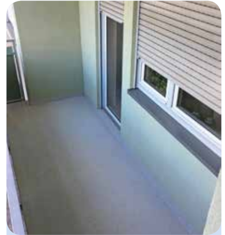
Innerhalb kürzester Zeit setzten die Verarbeiter die Balkone mit Flüssigkunststoff instand.
