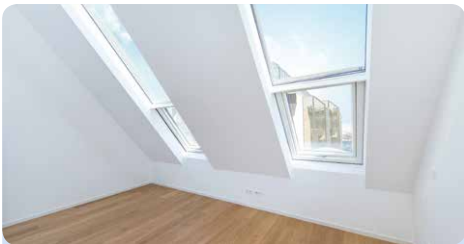
In direkter Zusammenarbeit der Planer mit FAKRO wurden konkret auf das Objekt abgestimmte Fenster- und Anschluss-Lösungen erarbeitet.
