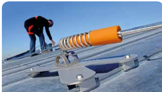
Absturzsicherungen montiert auf S-5! Klemmen.
