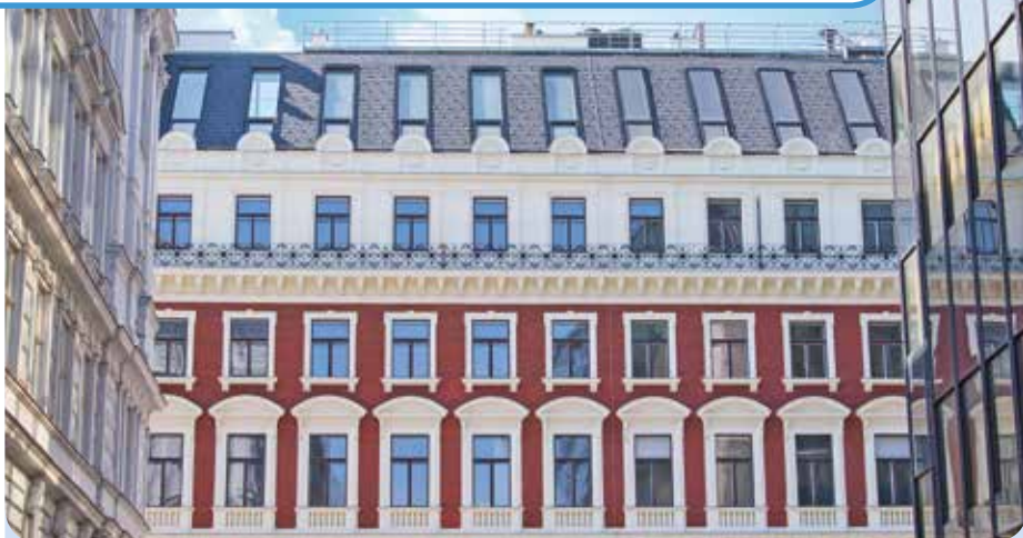
Fünf neue Dachgeschoßwohnungen mit großzügigen Terrassen sind durch den Dachausbau entstanden.
